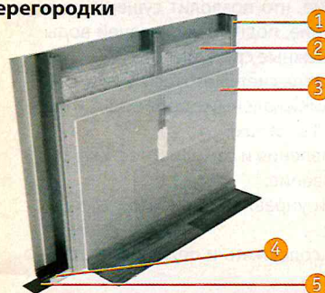
Рис. 1. Конструкция каркасной перегородки
